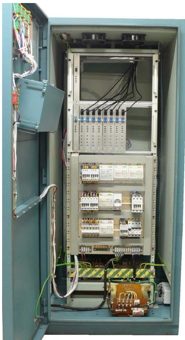
Rysunek 12: Wnętrze szafy sterowniczej robotów IRp6
